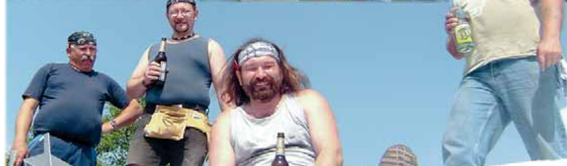
Eine eindrucksvolle Maschine faltete aus Aluminiumrollen ca. 13 m lange Schare, die die RCE-Arnateure den vier Klempner-Profis zureichten. Das Verlegen und alles Drumunddran lag in den Händen der Experten. Drei lange Arbeitstage dauerte es und das Dach war wieder dicht.
