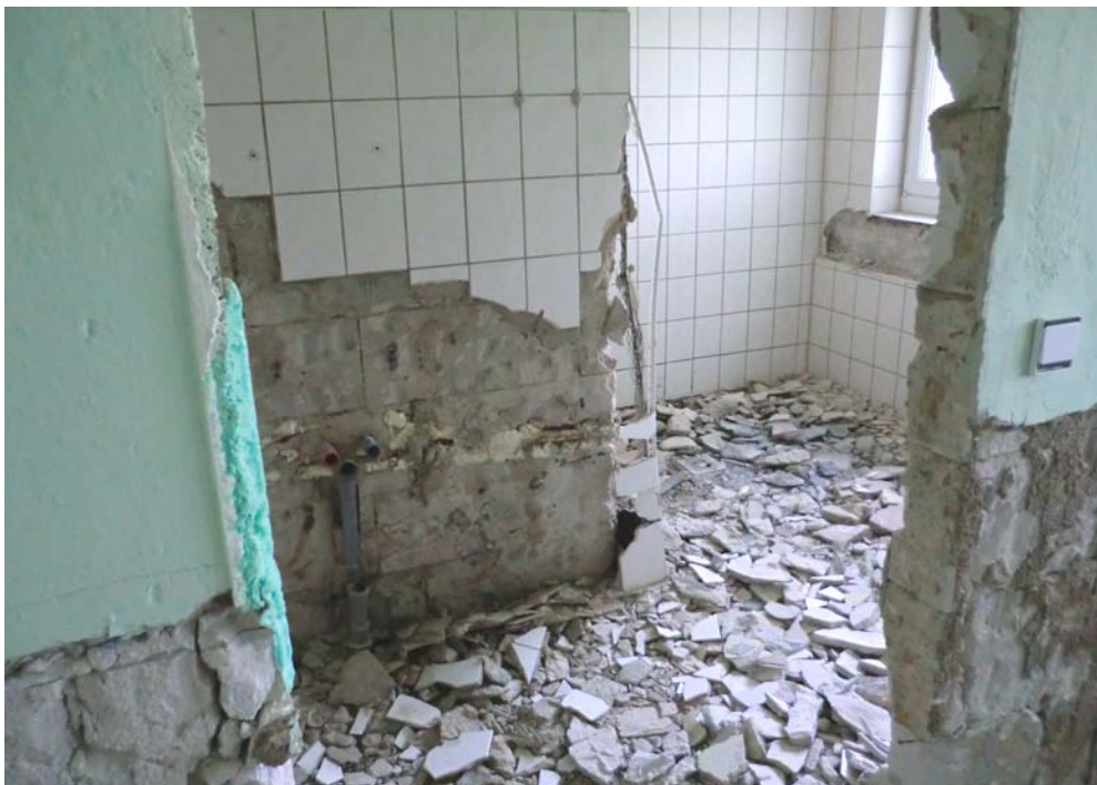
Hochwassersanierung 2014, Entkernung Sanitärbereich,
