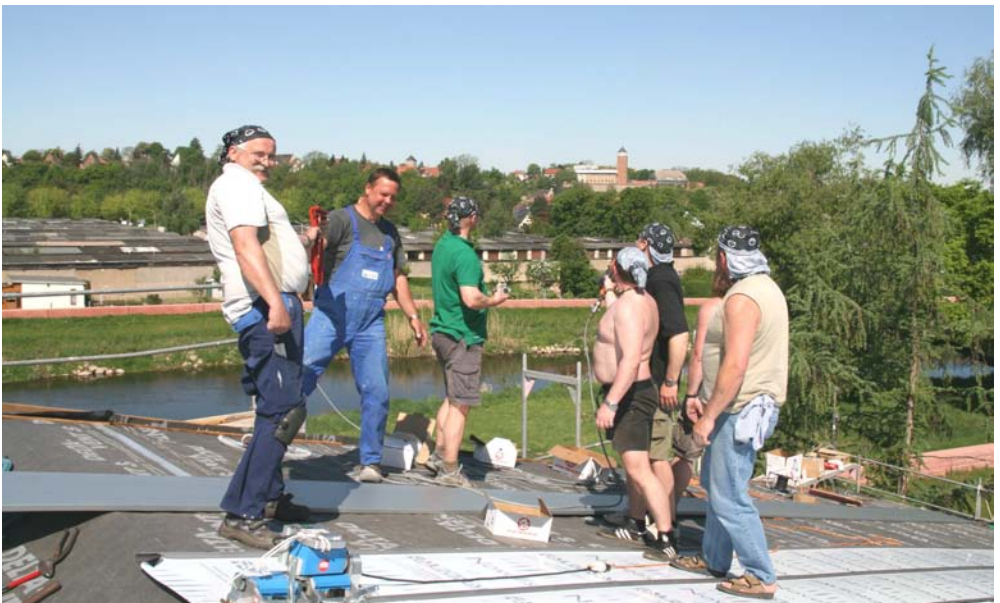
Bootshaus-Dachsanierung 2009, Steffen Scholz (2.v.l.)
